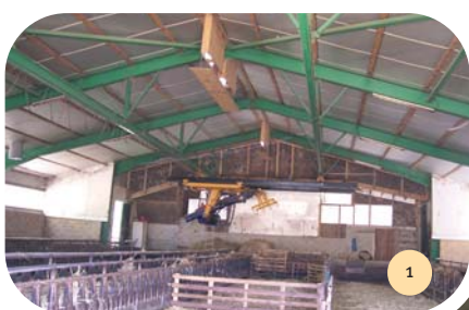
Vue intérieure du bâtiment.
