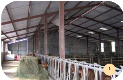
Vue intérieure du bâtiment avec couloir d'alimentation large.
