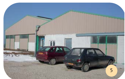
Vue des pignons côté laiterie.
