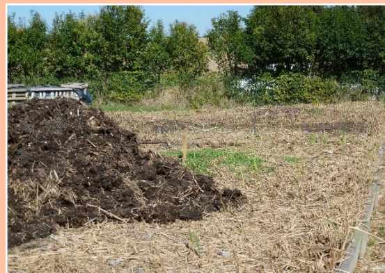
Filtres à sables plantés de roseaux
