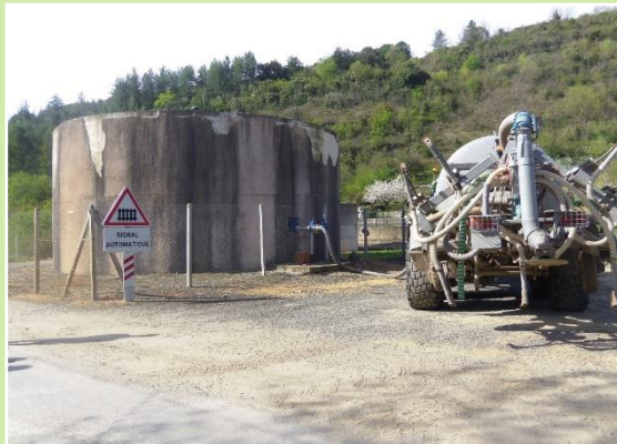
Silo de stockage
