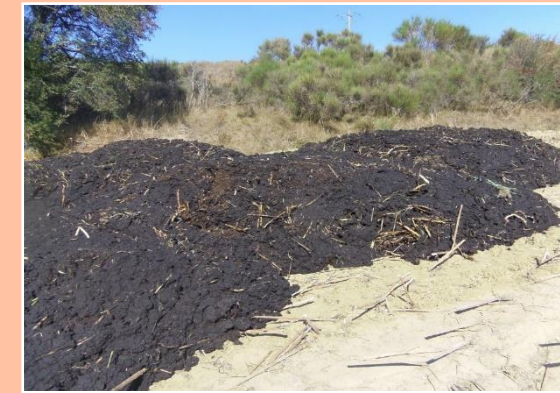
Lits de séchage plantés de roseaux
